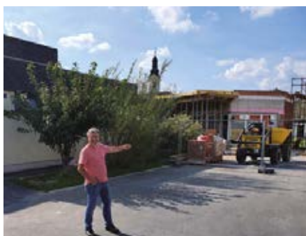
Bürgermeister Franz Pelzmann vor dem Kindergarten: die Arbeiten gehen voran Foto: GVV Burgenland
