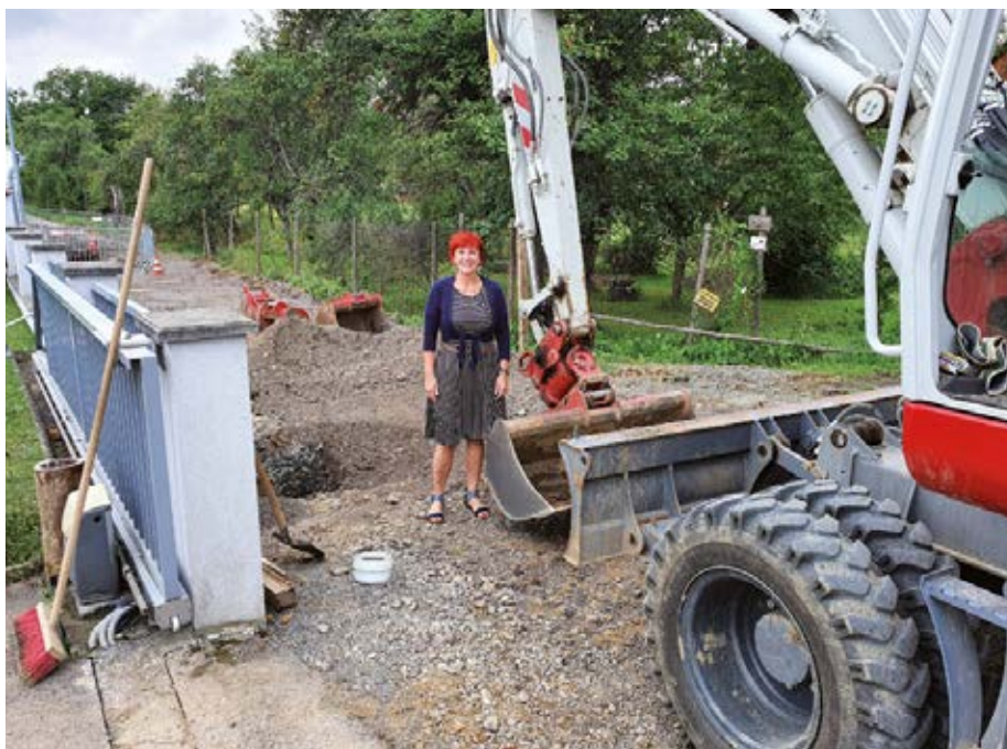
Bürgermeisterin Klaudia Friedl überzeigte sich vom Fortschritt der Arbeiten am Kanalsystem Foto: GVV Burgenland
